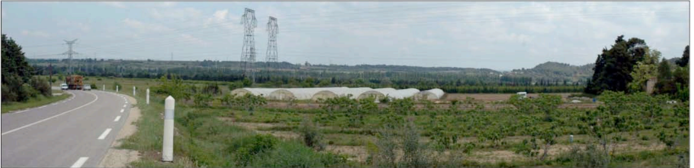
POINT DE VUE 1 : VUE DEPUIS LA RD 999 AU SUD-EST, SEUIL DU MAS DE SICARD, DÉBOUCHÉ DANS LA PLAINE DE JONQUIÈRES, PANORAMA PHOTO
