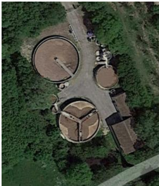
Vue aérienne de la station d'épuration.
